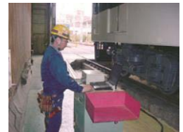
輪重測定装置による管理
