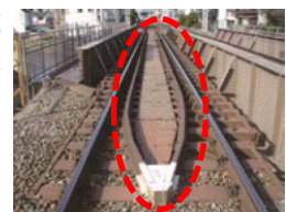
橋上ガードレール
