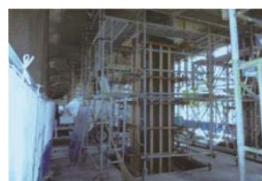
高架橋耐震補強
