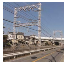
現況 （光善寺駅～枚方公園駅間）
