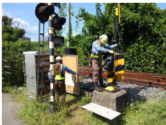
踏切保安装置の復旧訓練
