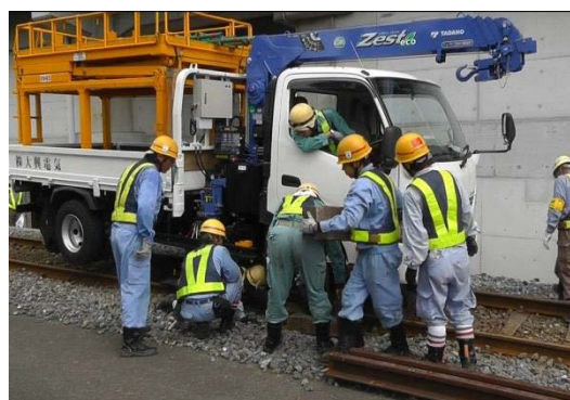
架線車の脱線復旧訓練
