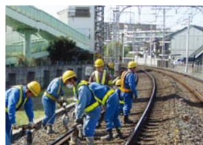
道床突固め作業
