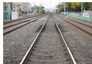
ロングレール
